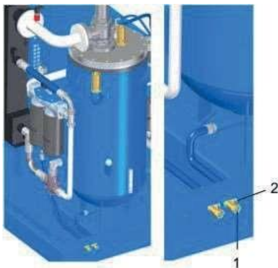
Рис. 40: Отверстие для слива масла
